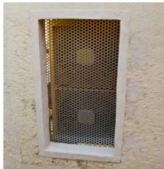
Exemples de traitement pour les échangeurs de climatiseurs.
